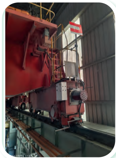
圖一：天車安裝自動伸縮卡軌器
