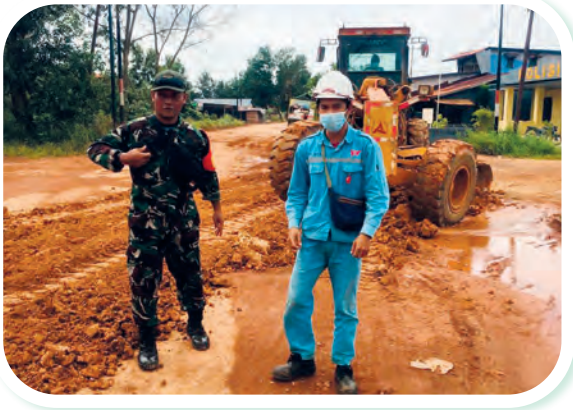
修復Sungai Tengar村省道
